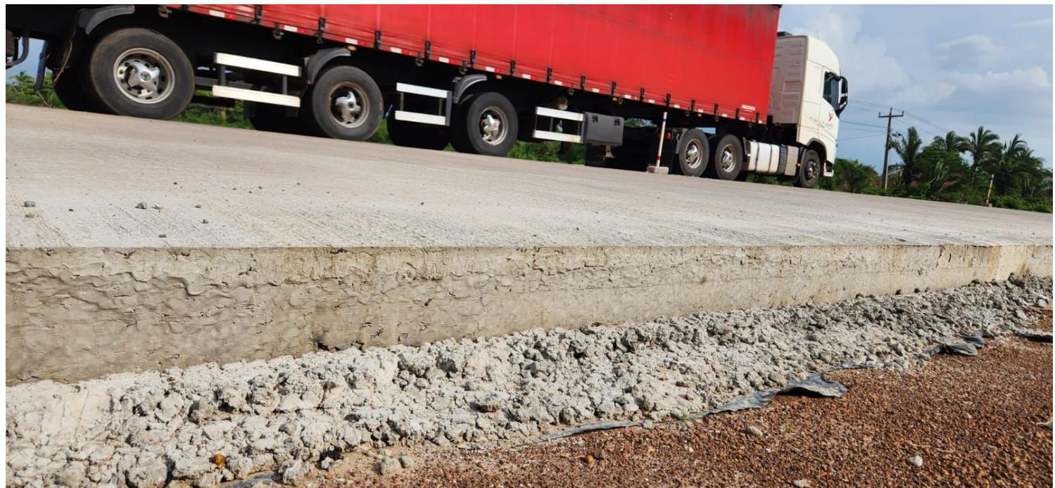
A ideia de construir a pavimentação em concreto naquele trecho da BR-135 foi do DNIT do Maranhão. Esta solução de engenharia irá resolver definitivamente as precárias condições da pavimentação asfáltica decorrentes das características do solo, e do grande tráfego de veículos pesados que diariamente utilizam a rodovia federal.
