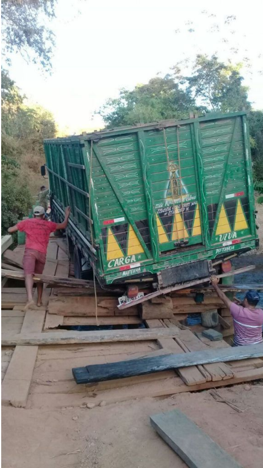
A situação em que se encontra a ponte
