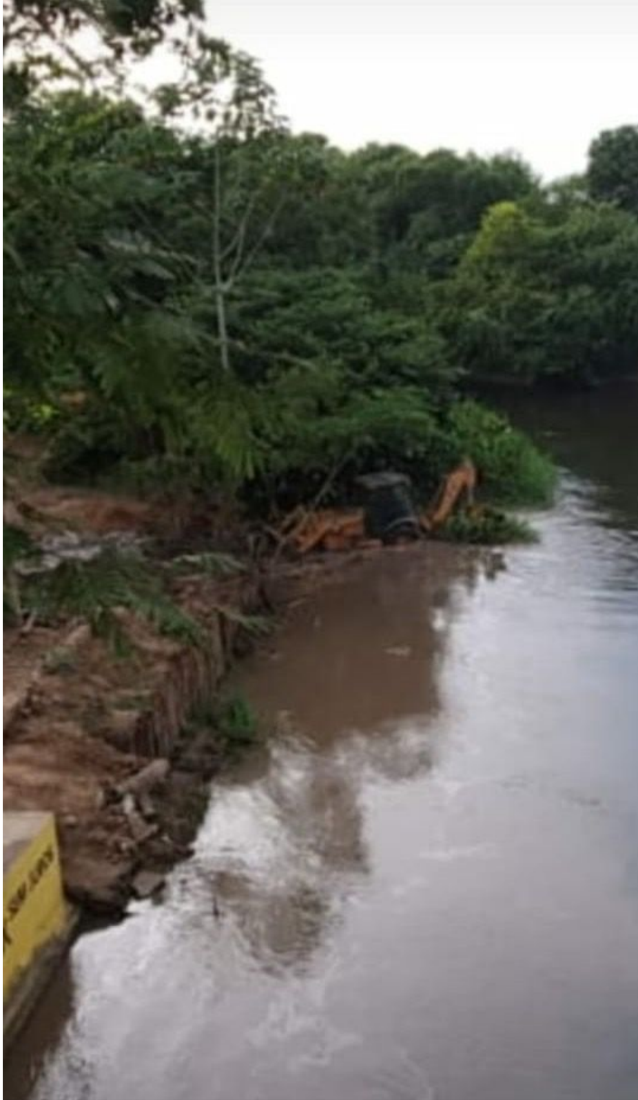
Uma retroescavadeira deslizou
